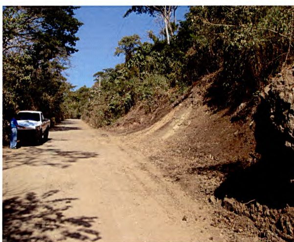
Remoción del material producto del deslizamiento.
